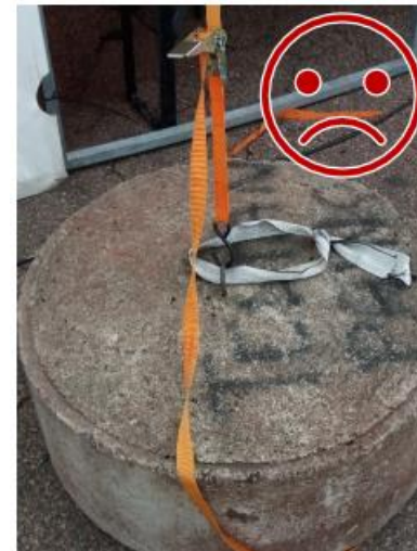
Kuva 12. S-koukku irtoaa rakenteen jousaessa tuulella. Kiinnitystä ei ole lukittu kiinnityspisteeseen.
