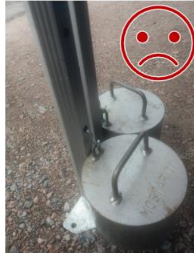
Kuva 10. Painojen teräskoukku ei ole lukittu. Teräs leikkaa alumiinia, jolloin kiinnitys ei ole toimiva.
