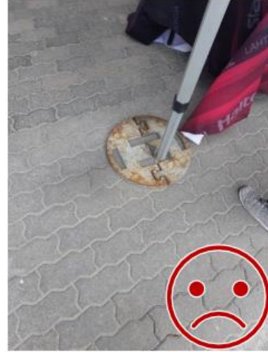
Kuva 2. Tolpan painolevy on liian pieni ja yhteensopimaton painon kanssa. Lisäksi tästä puuttuu toinen samanlainen paino poikittain lukitsemasta alemmaa painoa paikoilleen.
