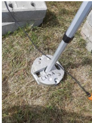
Kuva 1 EI NÄIN. Painojen lukitus toisiinsa puuttuu. Painot irtaavat painovoimaisesti, eivätkä pysy tolpan ympärillä tuulen ravistellessa telttaa.
