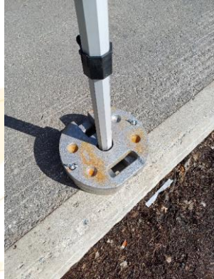
Kuva 2 HYVÄ TAPA. Molemmat painot kiinnitetty siipimutterilla molemmin puolin. Hevoskenkäpainot vastakkain, jolloin tolppa ei pääse irtomaan rakenteen liikkeessä. Kulmatolpan maajalan tulee kestää kyseinen paino.
