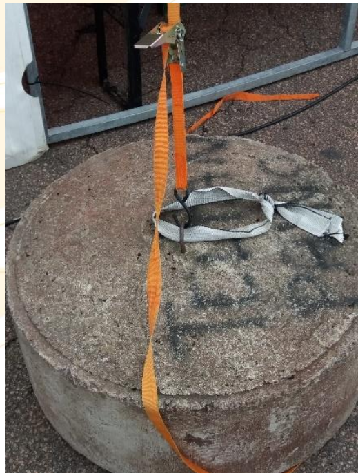
Kuva 7 EI NÄIN. S-koukku ei ole lukittava. Koukku irtoaa rakenteen liikkuessa.
