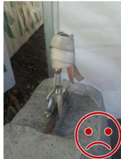
Kuva 8. Sakkeli löytyy, mutta tätä ei ole käytetty kiinnitykseen. Koukku irtoaa rakenteen jousaessa.
