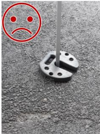
Kuva 7. Toinen vastaava paino puuttuu vastapuolelta sekä näiden lukitseminen toisiinsa, jolloin lukkiutuisi myös tolppaan. Kolojen yhteen sopiminen painovoimaisesti ei ole lukitseva.
