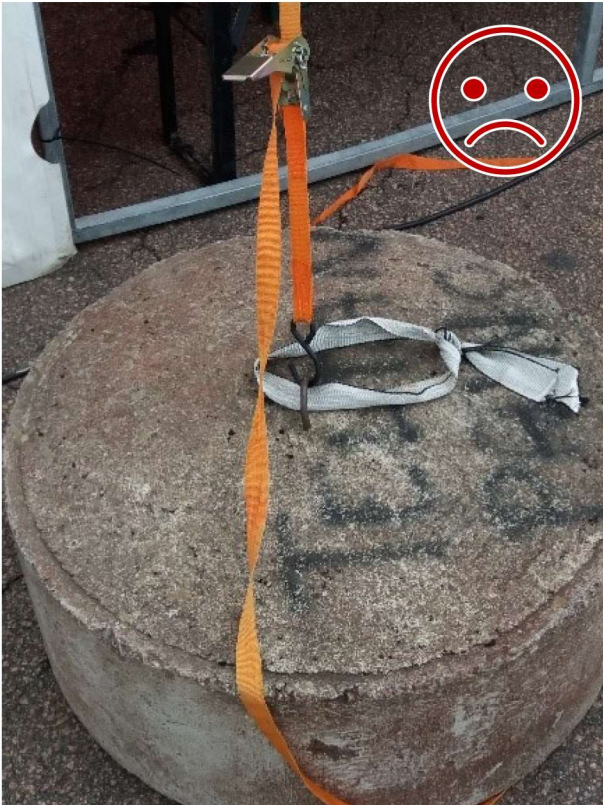
Kuva 7 EI NÄIN. S-koukku ei ole lukittava. Koukku irtoaa rakenteen liikkuesssa.
