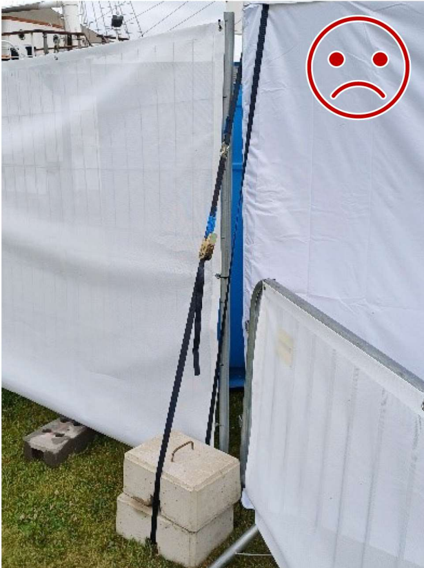
Kuva 11 Ei NÄIN. Painoja ei ole lukittu liinaan tai toisiinsa. Pino kaatuu eikä liina pidä rakenteen liikkuesssa.
