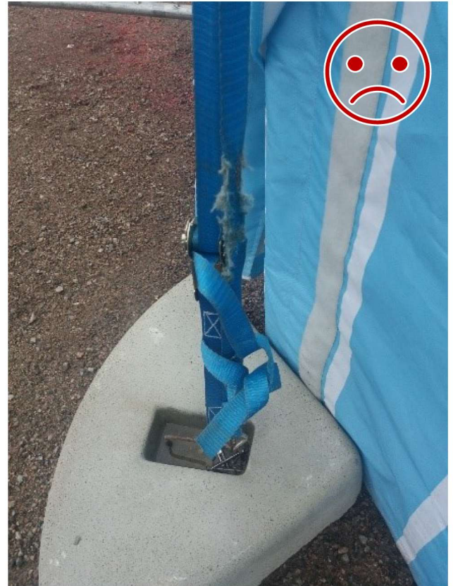
Kuva 10 Ei NÄIN. Kuormaliina on kulunut.
