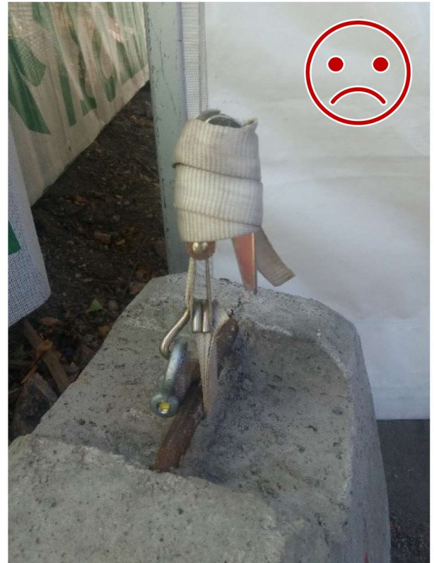
Kuva 6 EI NÄIN. Koukku ei ole lukittu, tulisi olla sokkelilla lukittu kiinnityspisteeseen koukusta.
