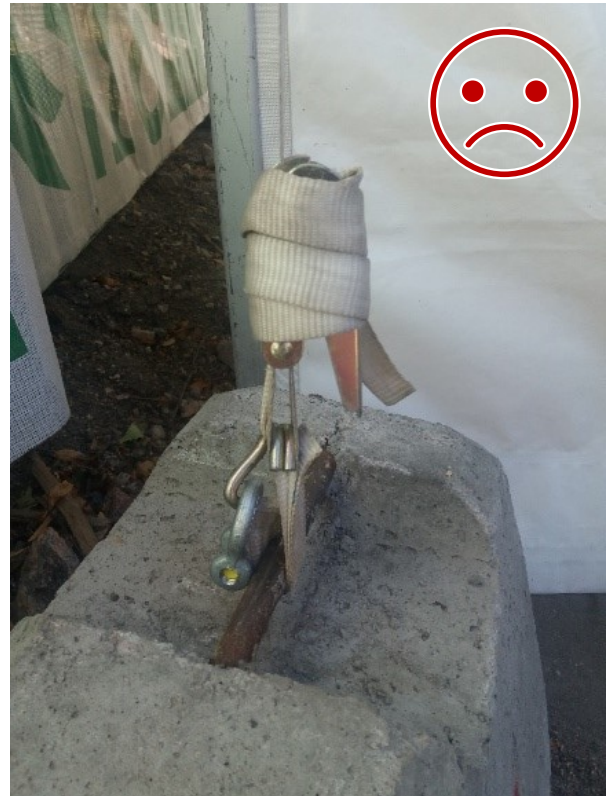
Kuva 6 EI NÄIN. Koukkua ei ole lukittu, tulisi olla sokkelilla lukittu kiinnityspisteeseen koukusta.
